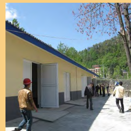
臥龍鎮垃圾收集站
