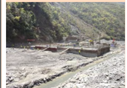
2011 年 4 月 (熊貓水電站)
