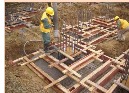
2011 年 9 月（基礎施工）
