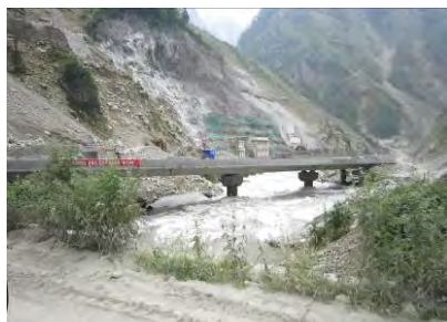
2010 年中洪災前完成工程
