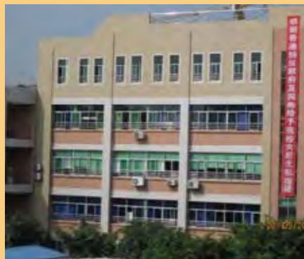
維修加固舊教學樓
