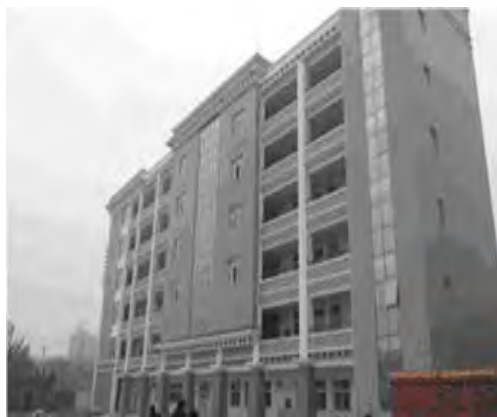
2010年3月 - 教學樓竣工情況
