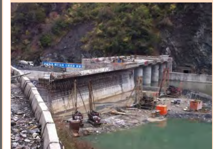
2012 年 4 月 (熊貓水電站)
