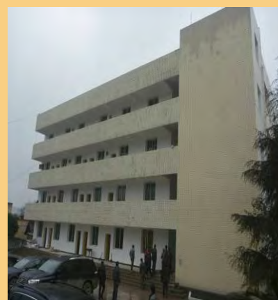
維修加固綜合樓
