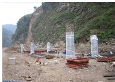
2010 年中洪災前完成工程
